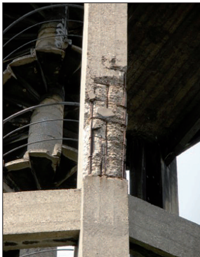
▲ et ▼ Corrosion d'armature spectaculaire sur un poteau de réservoir de stockage d'eau, référence [3].
