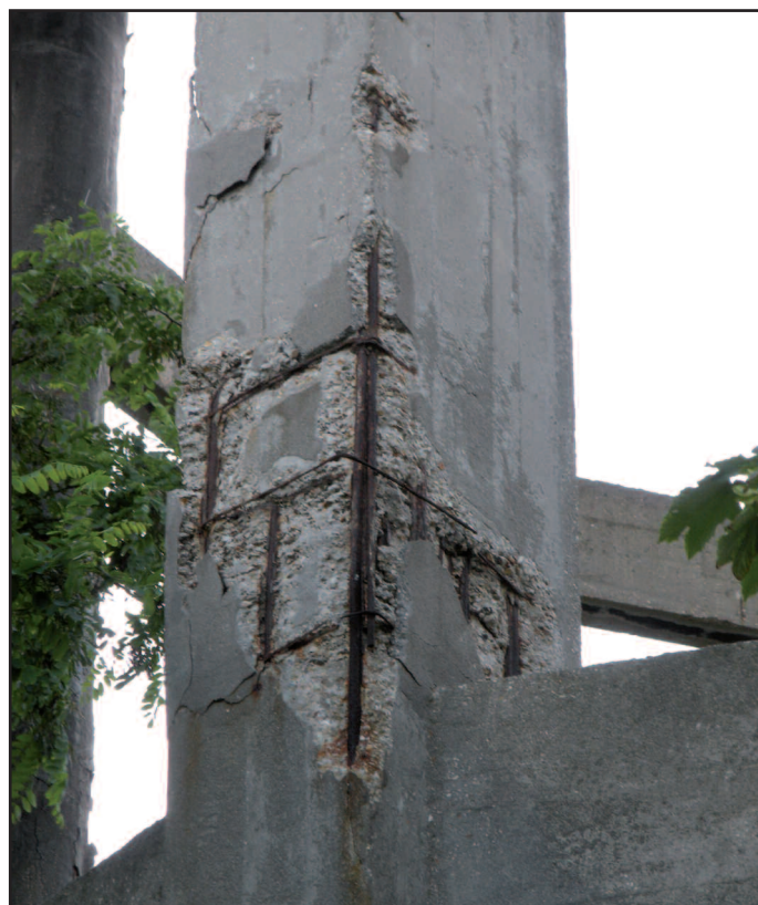
▲ et ▼ Corrosion d'armature spectaculaire sur un poteau de réservoir de stockage d'eau, référence [3].
