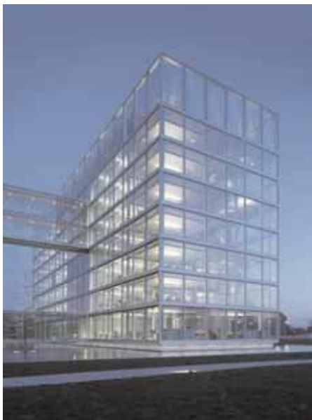
Fig. 1. Bâtiment équipé de vitrages à couches d'isolation thermique renforcée.
